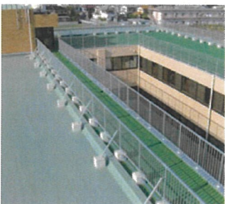
主成分EPDMの合成高分子系ルーフィングシート
