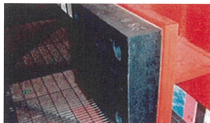
落橋防止システム (PRF緩衝材)
