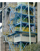
▲廃プラ吹込設備
