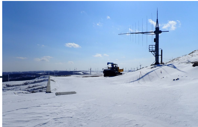
宗谷(4)機内通信線路等整備工事
