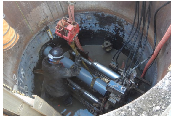
公共施工事例...
