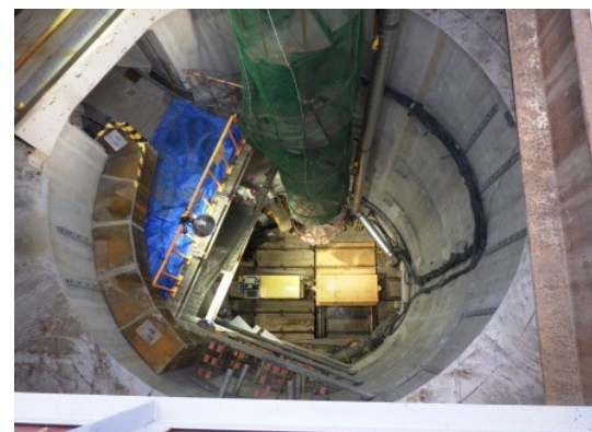
民間施工事例...
