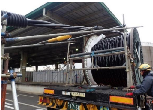
ケーブル布設
