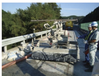
橋梁部の床版はつり
