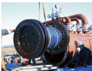
配管洗浄 PIG
