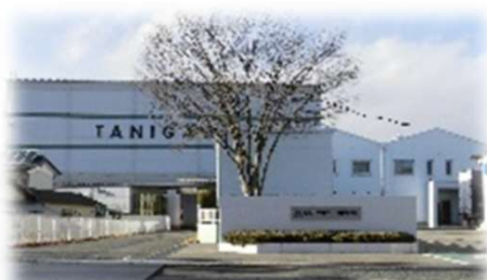
▲タニガワプラント（みなかみ町）
