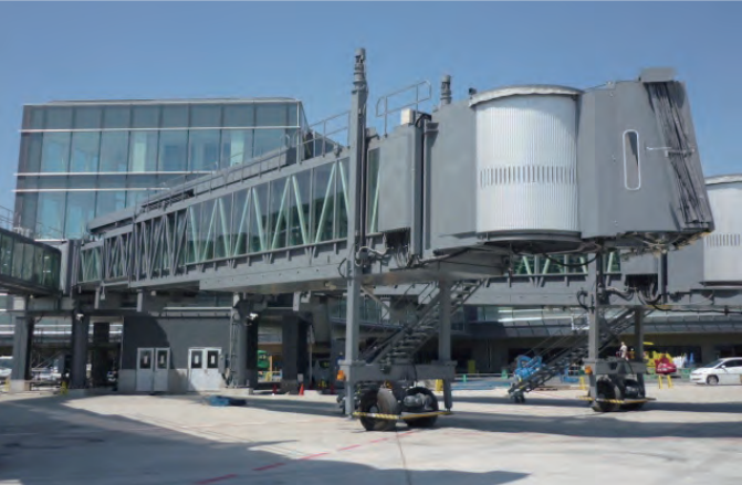
東京国際空港国際線(ガラスタイプ)
