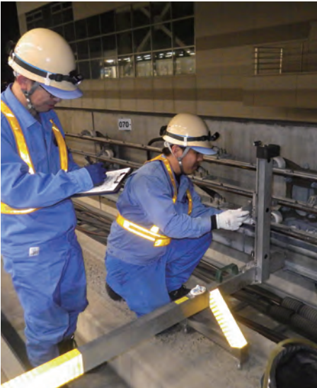
新交通軌道設備保守点検
