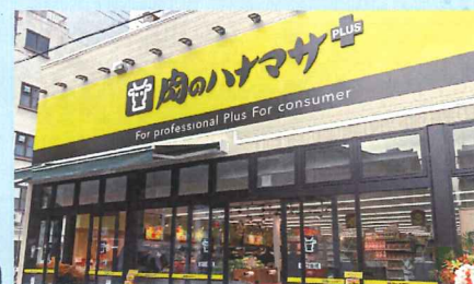
大阪府大阪市 肉のハナマサPLUS 大国町店 設計・施工 (内装・設備・厨房)
