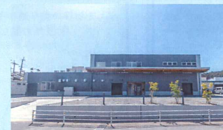
京都府綴喜郡 上尾製菓 新工場 設計 (建築・設備・厨房)・施工 (建築・設備・内装)
