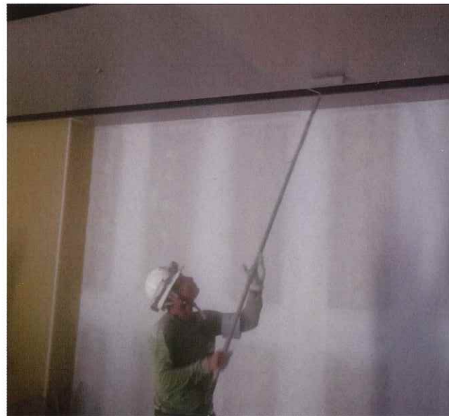
ローラーでの天井塗装作業
