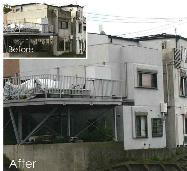
打ちっばなしコンクリート外壁を復活
