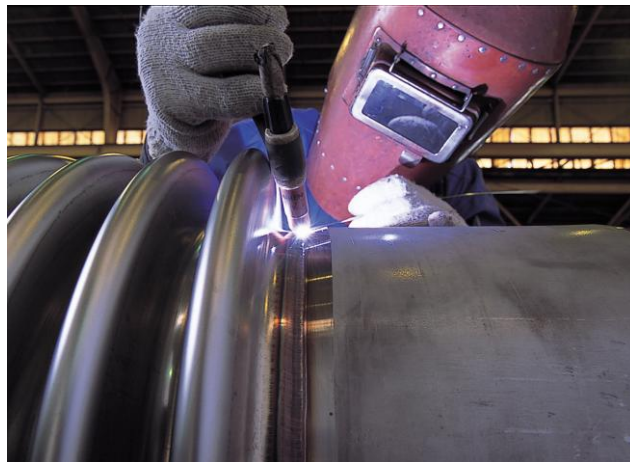
ベローズ周継手 TIG溶接
