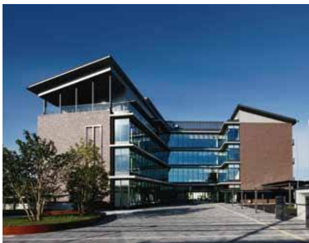
安来庁舎建設工事
