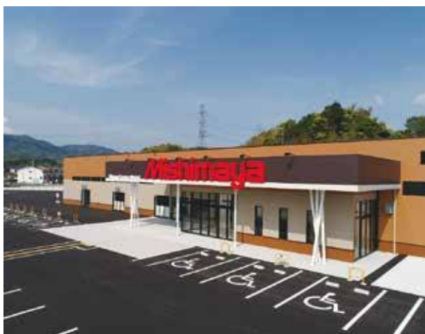
みしまや東川津店新築工事
