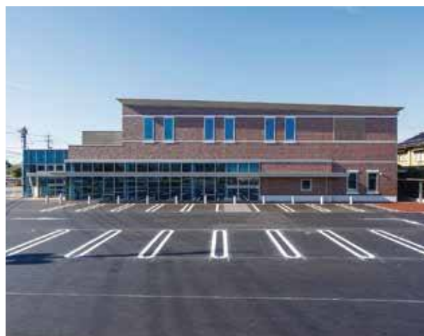
山陰合同銀行安来支店新築工事
