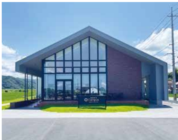
桜苑 製菓・製パン工場、販売店舗、喫茶室新築工事
