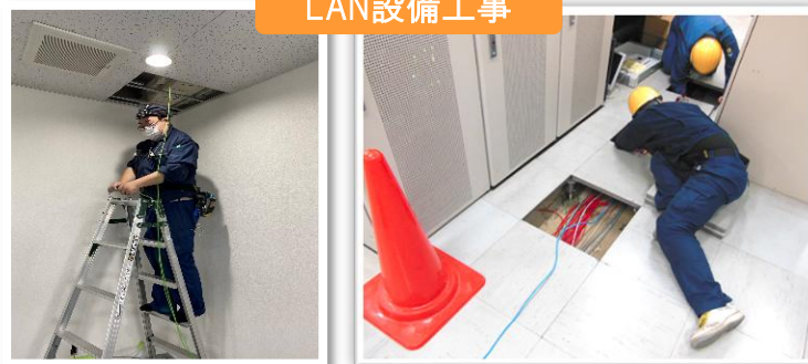
LAN設備工事
