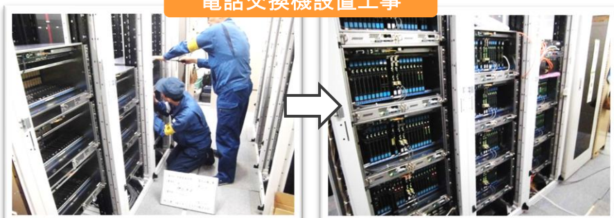
電話交換機設置工事
