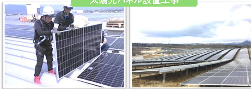
太陽光パネル設置工事
