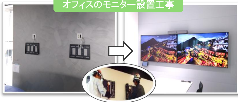
オフィスのモニター設置工事
