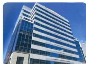
立川市曙町 地域熱供給施設
