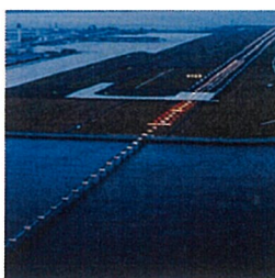
航空灯火工事
