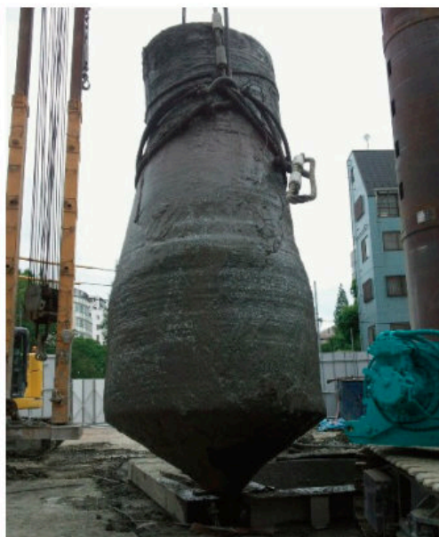
軸径Φ1800- 拡底φ2500 杭
