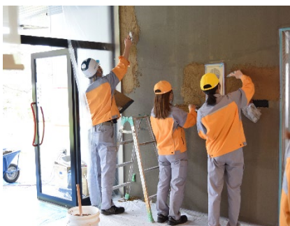
食堂の土壁塗り
