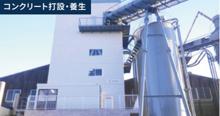
コンクリート打設・養生
