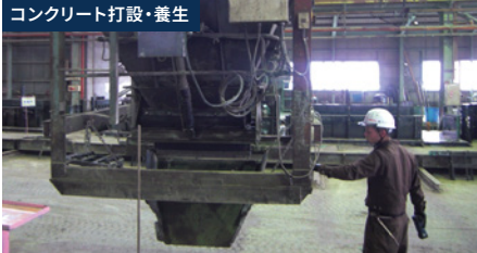
コンクリート打設・養生
