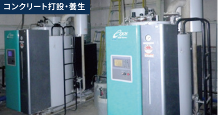
コンクリート打設・養生
