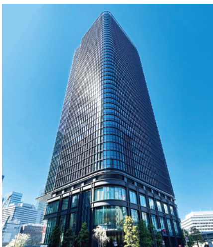
常盤橋タワー
