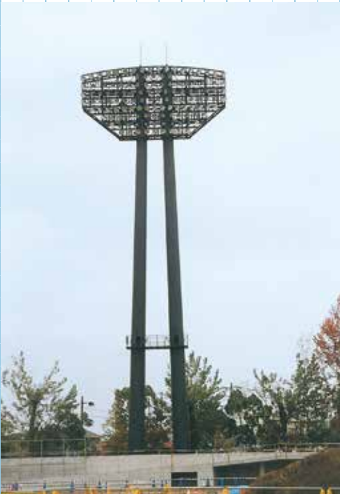
岡山県営陸上競技場照明塔
