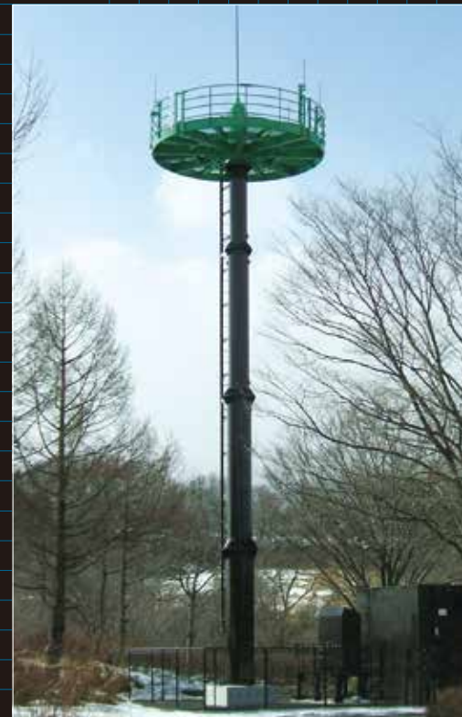
防災行政無線鉄塔
