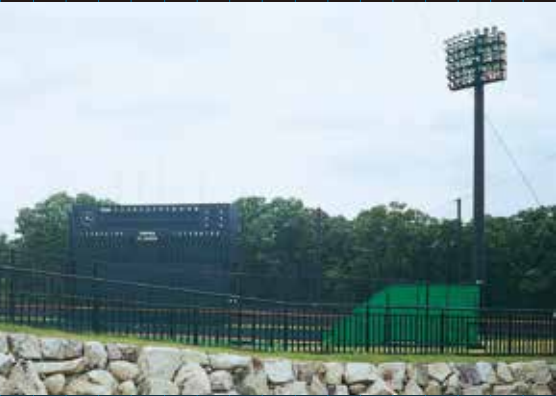
北神戸田園スポーツ公園野球場 スコアボード及び照明塔
