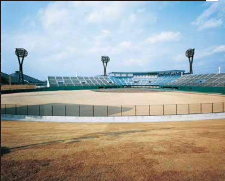
岡崎中央総合公園野球場照明塔
