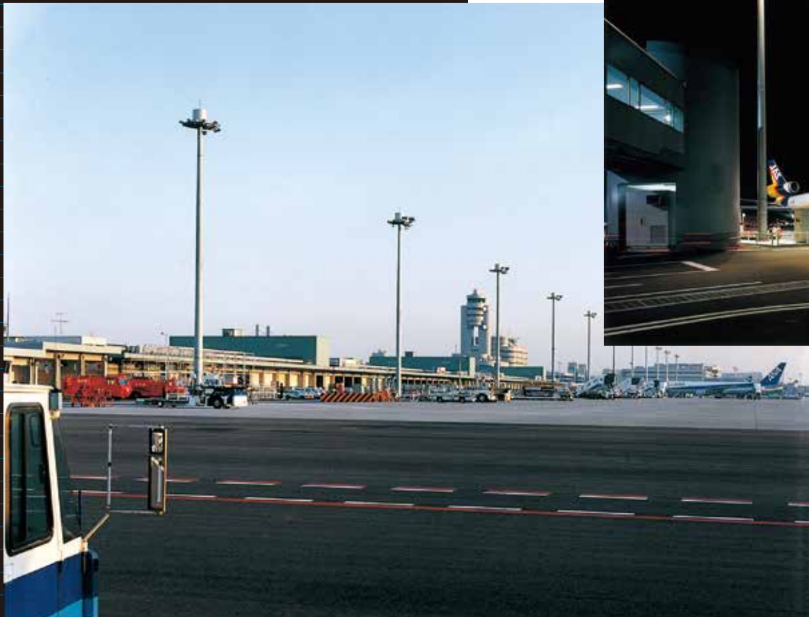
東京国際空港 昇降式照明塔
